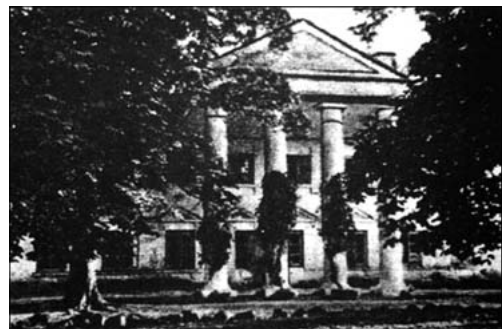
Oddziedziczony dwór Rodziewiczów w Hruszowej, 1936
