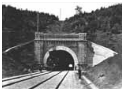
Tunel zbudowany przez Pawła Mielnikowa
