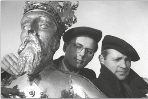
Kazimierz Macur – z prawa – z inż. architektem Zygmuntem Reinhardtem przy posągu króla Zygmunta Augusta, który w 1950 powrócił na szczyt wieży Ratusza w Gdańsku. Zdjęcie z archiwum prywatnego
